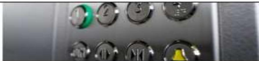
другой необходимой информацией (на кнопках или над ними). Следует предусматривать автоматическое звуковое и визуальное оповещение о номере этажа, на котором останавливается лифт. Расположенный в кабине аппарат двухсторонней переговорной связи с диспетчерским пунктом должен быть промаркирован шрифтом Брайля и снабжен устройством для усиления звука, а при необходимости — устройством для получения синхронной визуальной информации.
